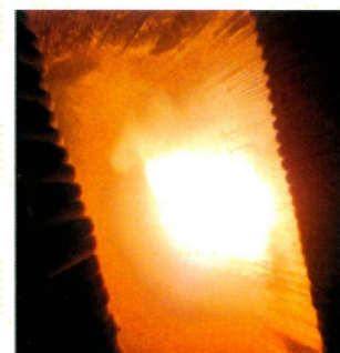
Вид факела на котле ТП-10 ст. №1 ТЭЦ-10 филиал ПАО «Иркутскэнерго» при растопке высокочастотным электрохимическим запальным устройством.
